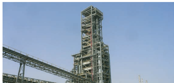
Qatar Steel Module 2
